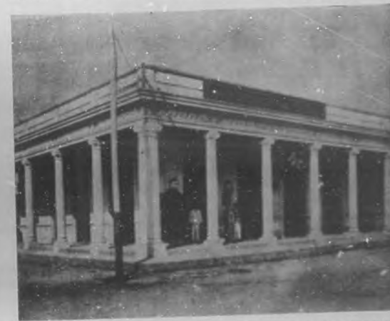
LA SUCURSAL DEL BANCO INTERNACIONAL EN BOLONDRON Fachada del Banco.
